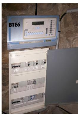
Les équipements du tableau électrique, installé provisoirement pour les illuminations lors des fêtes de fin d'année, ont été intégrés à l'armoire principale de l'église par le personnel communal accompagné d'un élu.
