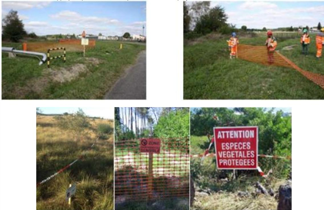
Exemple de mise en place d'un balisage d'un site sensible vis-à-vis d'un projet d'aménagement
